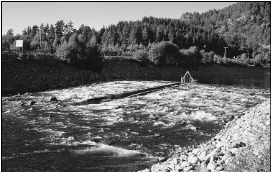
Løsmasseterskel med fisketrapp i betong og felle ved Laudal nederst i den undersøkte delen av Mandalselva (se kart på neste side).
